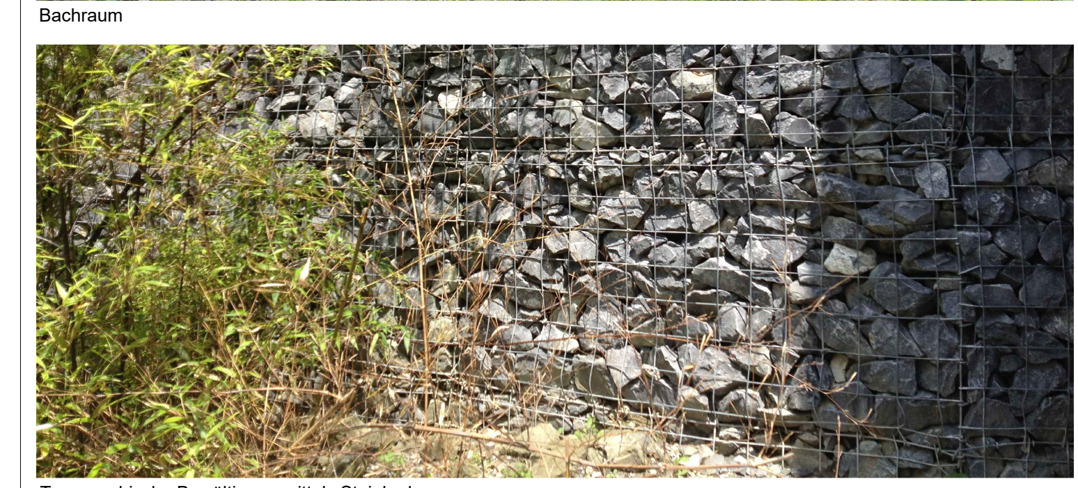
Topographische Bewältigung mittels Steinkorbmauern
